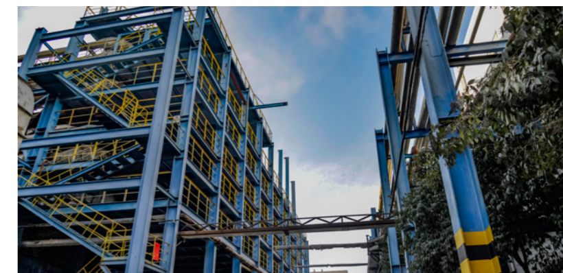
中铝矿业有限公司氧化铝厂进行高温溶出机组改造，实现能源二次利用，减少碳排放
