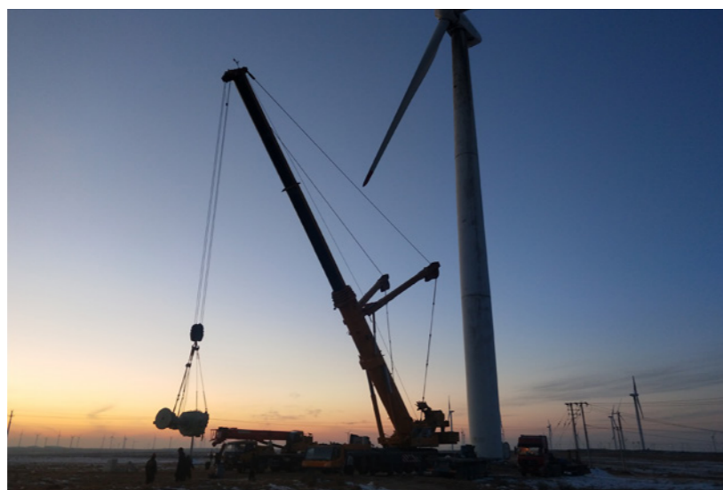
银星能源风电建设项目施工现场
