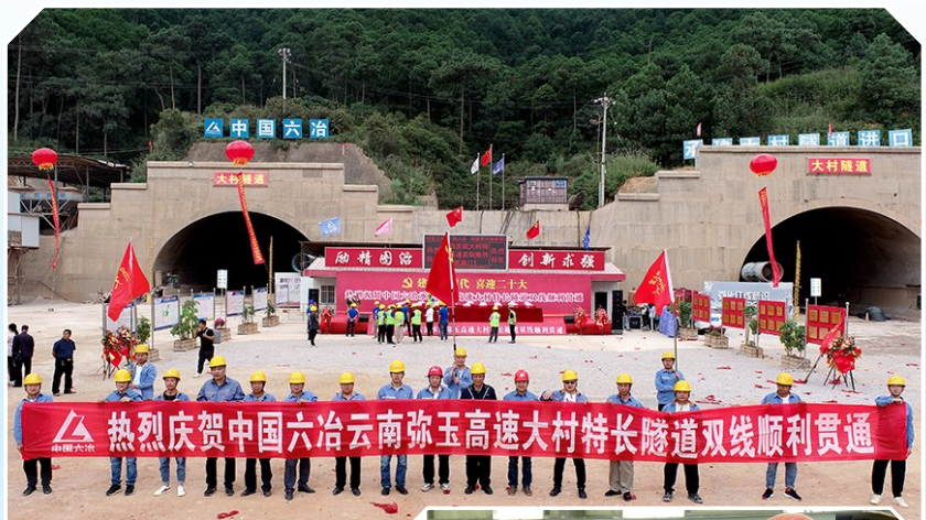
▲六冶隧道软弱围岩施工等技术达到国内先进水平。图为应用了该技术的云南弥玉大村特长隧道于2022年7月实现双线贯通。 胡智 摄
